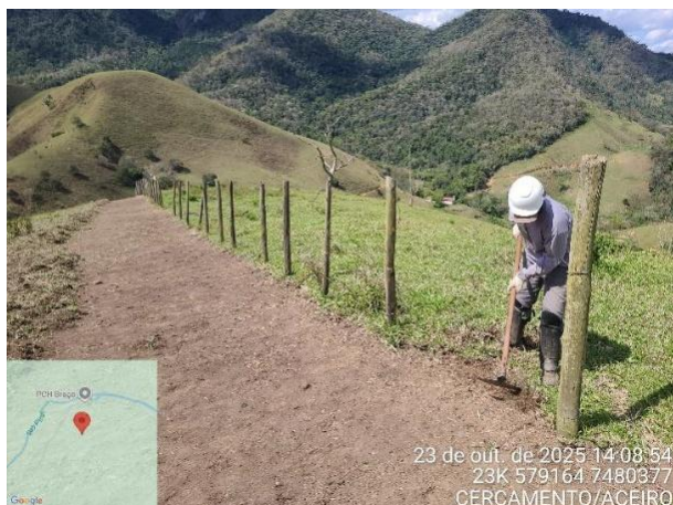
Figura 5-19 – Cercamento do perímetro.
