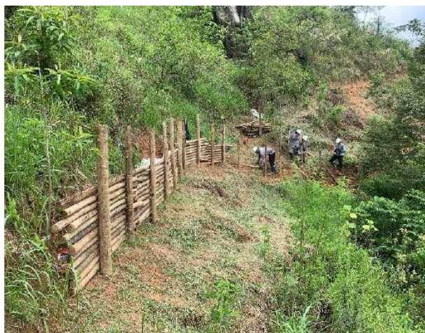
Figura 5-16 – Construção de paliçada.
