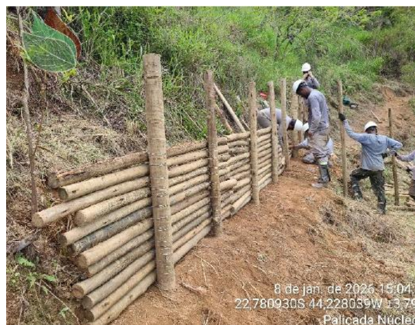
Figura 5-22 – Fixação dos moirões de eucalipto para construção da paliçada.
