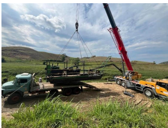
Figura 5-33 – Mobilização da balsa de dragagem.
