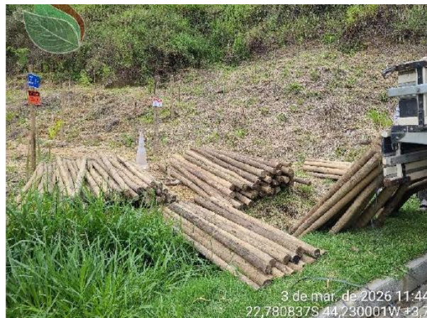
Figura 5-15 – Moirões de eucalipto utilizados na paliçada.
