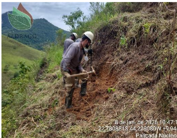
Figura 5-21 – Estruturação do terreno para alocação da paliçada.
