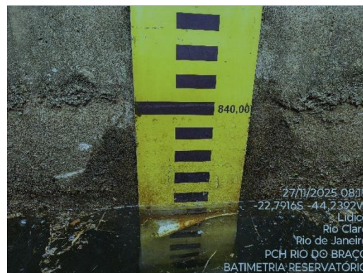
Figura 5-43 – referência de nível da barragem (839,57m).
