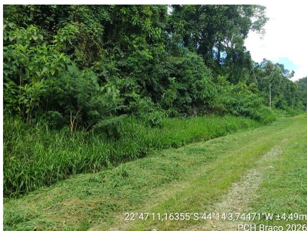
Figura 5-9 – Canaleta de drenagem nas laterais do acesso ao empreendimento.
