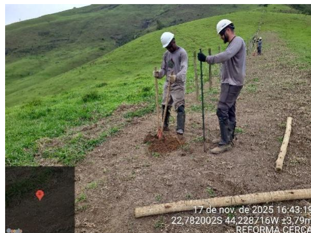
Figura 5-20 – Cercamento do perímetro.
