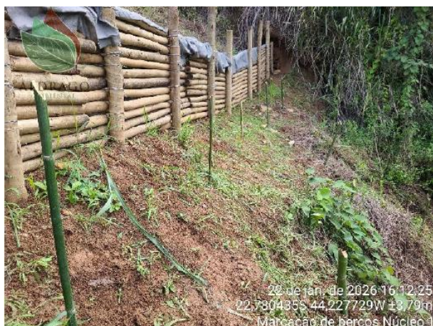
Figura 5-23 – Marcação dos berços de plantio.
