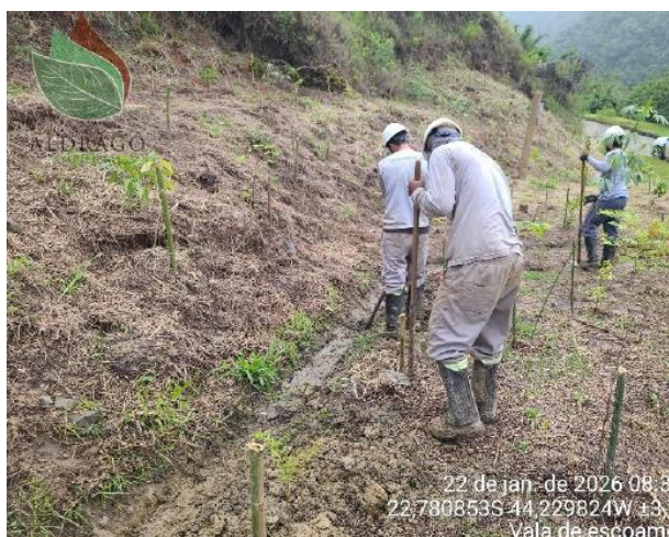
Figura 5-12 - Melhoramento/reabertura da vala de escoamento de água.
