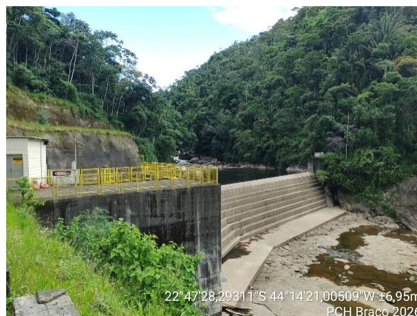
Figura 5-10 – Panorama geral do reservatório.
