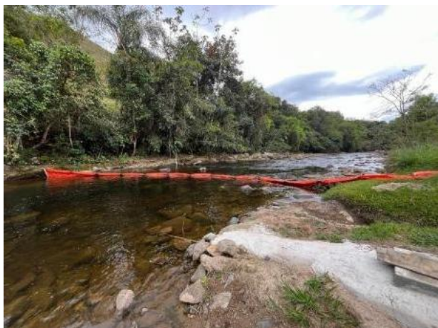
Figura 5-37 – Barreira de contenção à jusante.
